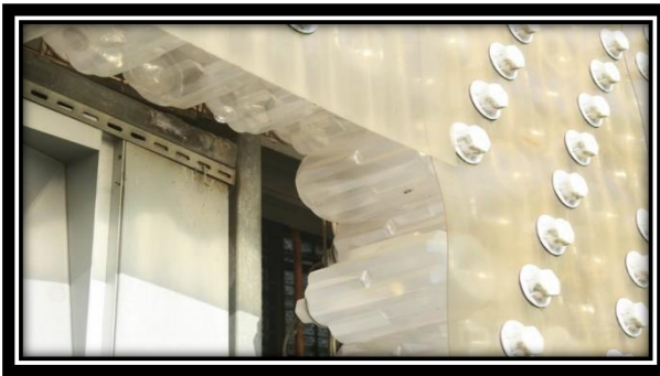
Figura E - blocos ocos de PET reciclado chamados de Polli-Bricks
