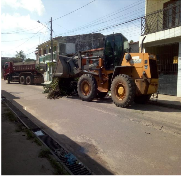
Figura 5: Trabalhadores retirando os resíduos da rua.
