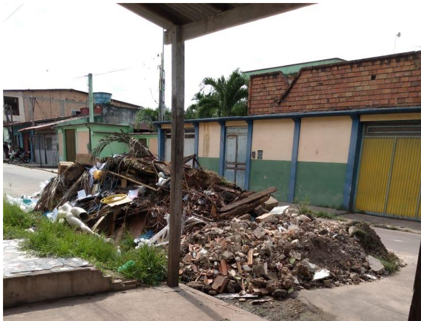
Figura 2 –Resíduos de uma obra de Abaetetuba-PA.
