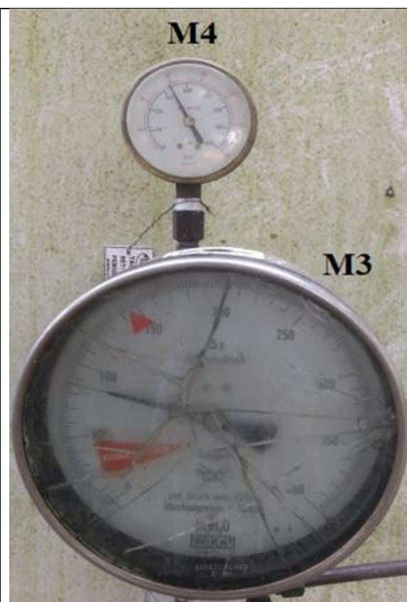
Figura 2: Manômetros do tanque criogênico de oxigênio líquido
