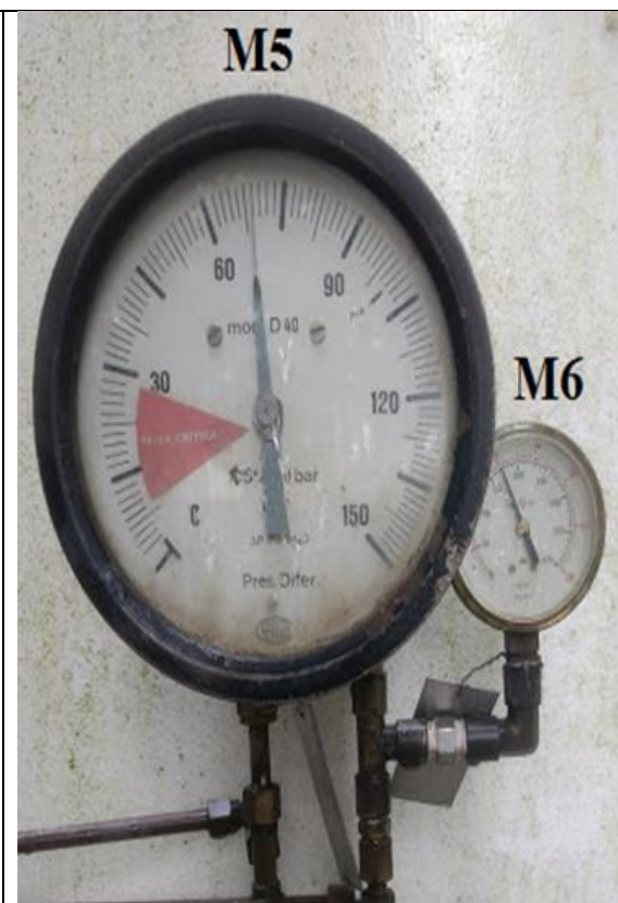
Figura 6: Manômetros do tanque criogênico de nitrogênio líquido
